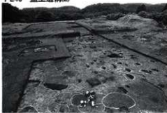
奥(南側)が盛土部分
