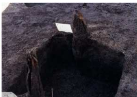
f. 同上 5層丸太杭打ち込み状況⑤
