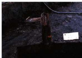
g. 同上 5層丸太杭打ち込み状況⑥
