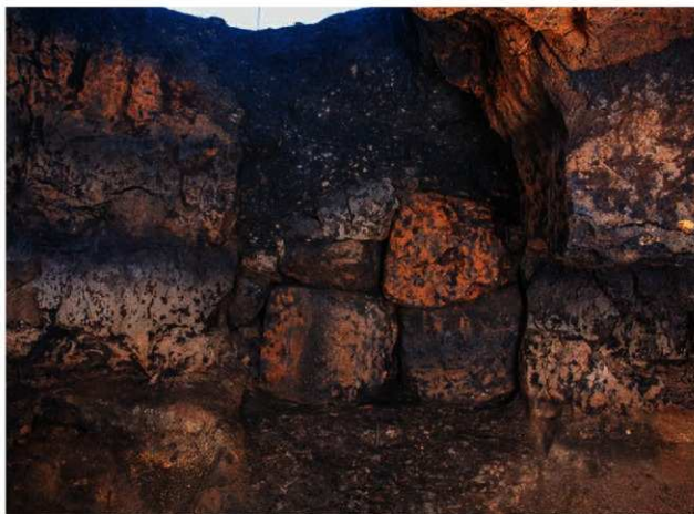
同 羨道土塊閉塞状態（北から）
