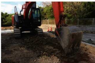
5 機械掘削状況
