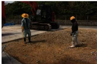
4 磁気探査状況
