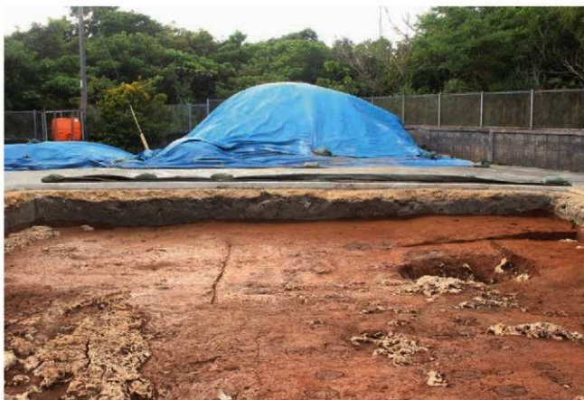
1 調査区 南西壁 完掘状況 (北東から)
