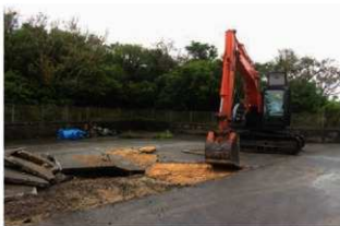
3 コンクリート撤去状況
