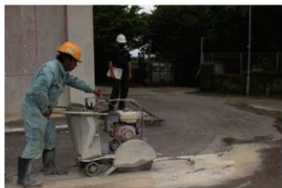
2 コンクリート切断状況
