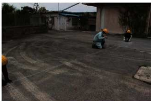
1 調査区位置出し状況
