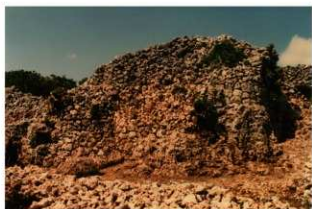
図版 12. 測量箇所（南の虎口跡 東側より）
