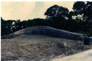
図版 53. 城壁修復工事竣工（南側より）
