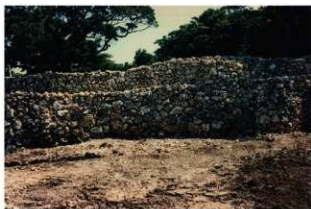
図版 87. 城壁修復工事竣工（南西側より）
