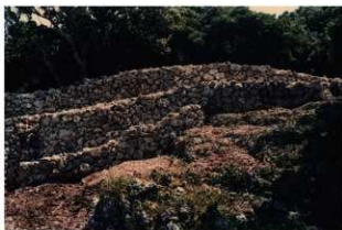
図版 88. 城壁修復工事竣工（南西側より）
