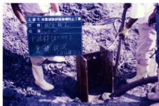
図版 70. モルタル充填状況
