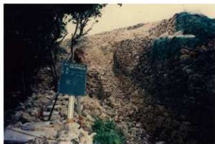
図版 112. G付近城内側竣工（南側より）
