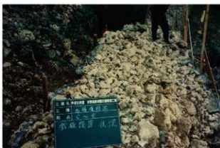
図版 99. 城壁積直し状況（北東側より）
