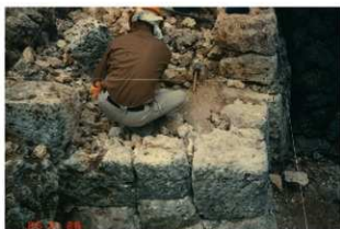
図版 17. 正門修復工事（南側より）
