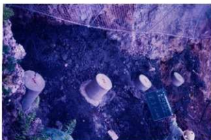
図版 72. 抑止杭工完了
