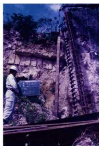
図版 68. H型钢建込状況
