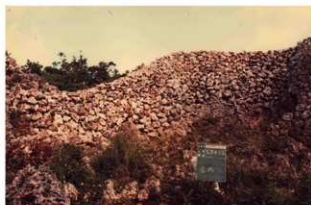
図版 45. 城壁修復工事竣工（東側より）
