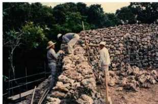
図版 50. 城壁積直し状況（南西側より）
