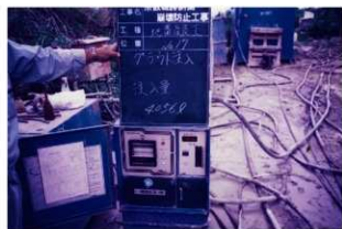
図版 81. グラウト注入
