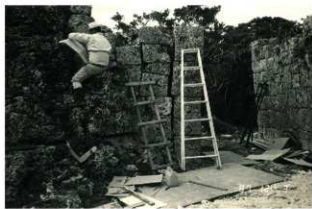
図版 10. 正門修復前（城外 南東側より）
