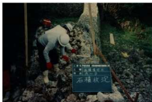
図版 100. 城壁積直し状況（北東側より）
