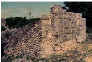
図版 20. 工事竣工状況（城内 南西側より）
