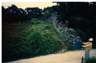
図版 47. 城壁修復工事着工前(東側より)
