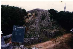
図版 107. 城壁修復工事着工前（南側より）
