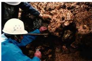
図版 93. 鉛板設置状況
