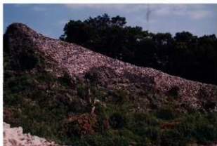
図版 101. 城壁修復工事竣工（西側より）
