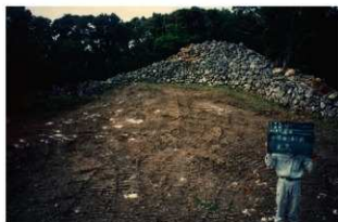
図版 48. 城壁修復工事着工前(南側より)
