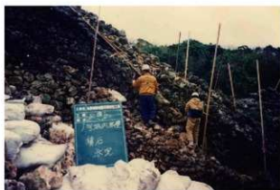
図版 104. E'～F' 城内側積石状況（西側より）
