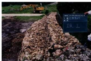
図版 59. 城壁修復工事竣工（南東側より）
