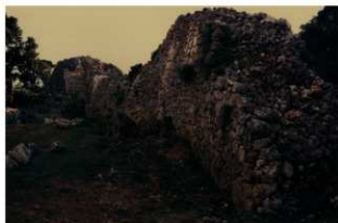
図版 24. 測量箇所 (城外正門北側 北側より)
