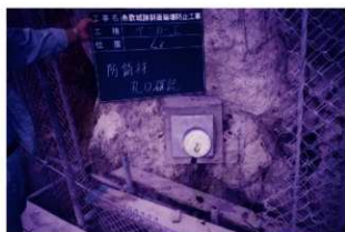
図版 79. 防錆材孔口確認
