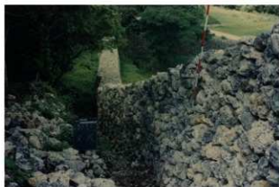
図版 102. 城壁修復工事竣工（北東側より）
