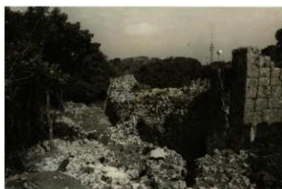
図版 8. 測量箇所（城内正門北側 南側より）
