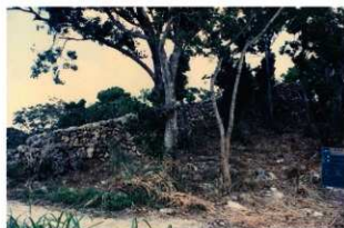
図版 52. 城壁修復工事竣工（北東側より）
