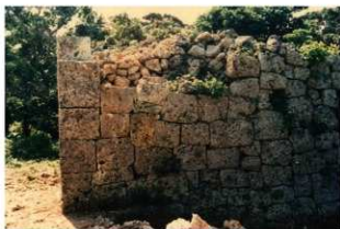
図版 19. 工事竣工状況（城外 東側より）
