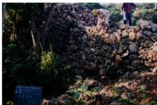
図版 56. 城壁積直し状況（北東側より）
