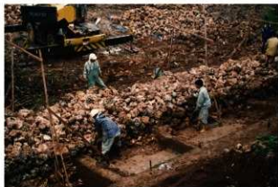
図版 92. 城壁積直し状況（南側より）
