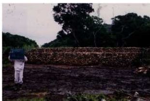
図版 60. 城壁修復工事竣工（南西側より）
