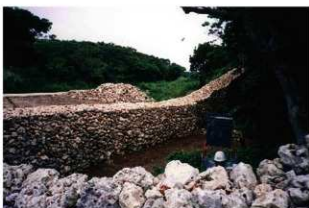
図版 94. 城壁修復工事竣工（南側より）
