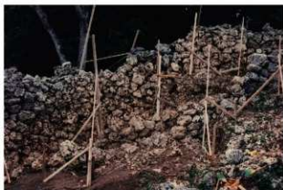
図版 84. 城壁積直し状況（南西側より）
