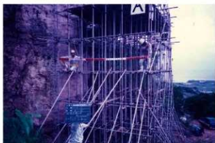
図版 73. アンカー工仮設足場設置
