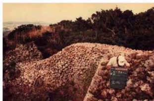
図版 46. 城壁修復工事竣工（北東側より）
