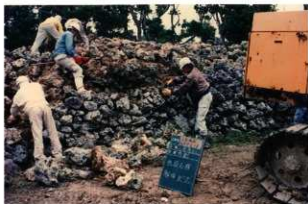
図版 49. 城壁解体状況（南側より）
