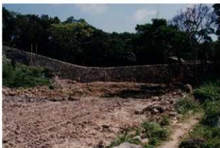
図版 96. 城壁修復工事竣工（北西側より）
