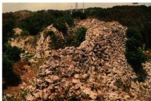
図版 3. 測量箇所（正門南側城壁 南側より）
