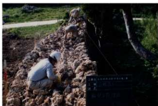
図版 57. 城壁積直し状況（南東側より）
