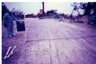
図版 82. 材料検収 (転落防護網)
