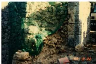
図版 15. 正門修復工事（城内 南西側より）
