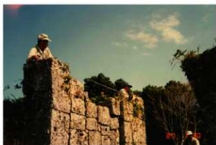
図版 5. 測量箇所（正門北側 南側より）
