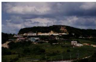
図版 61. 斜面崩落箇所遠景 (南西側より)
