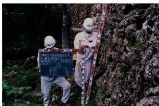
図版 58. 城壁勾配確認状況（北西側より）
