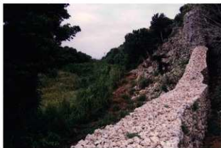
図版 95. 城壁修復工事竣工（南西側より）
