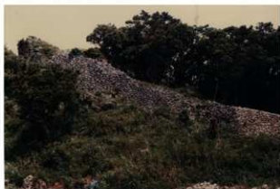
図版 97. 城壁修復工事着工前（西側より）
