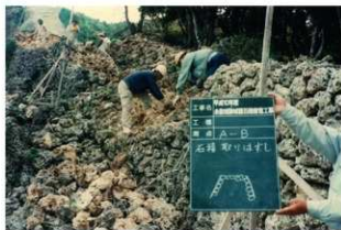
図版 98. 城壁積直し状況（南西側より）
