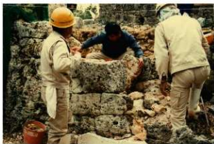
図版 16. 正門修復工事（城内 南西側より）
