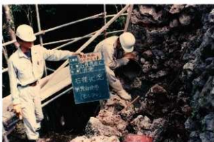
図版 51. モルタル流し込み状況（南西側より）
