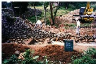
図版 90. 城壁積直し状況（東側より）
