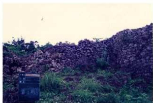
図版 43. 城壁修復工事着工前（東側より）
