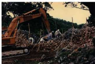
図版 85. 城壁積直し状況（南側より）
