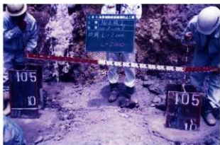
図版 71. 杭間確認
