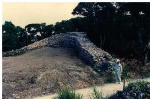
図版 54. 城壁修復工事竣工（南東側より）
