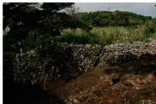
図版 89. 城壁修復工事着工前（東側より）
