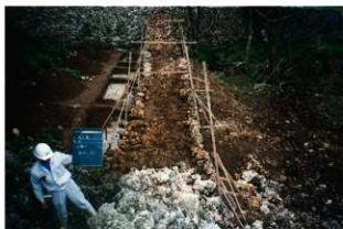
図版 91. 城壁積直し状況（北東側より）
