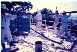
図版 74. アンカー体挿入状況
