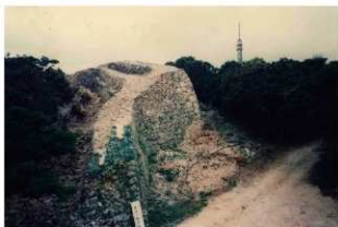
図版 108. 城壁修復工事竣工（南側より）
