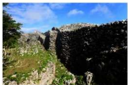
南のアザナから南の虎口の状況（城内）
