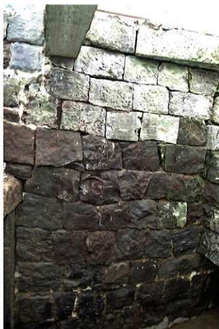
1号水路南端部西壁面
