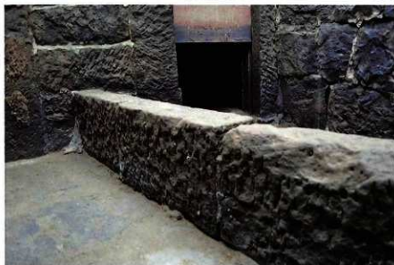
1号用水路南端部水路仕切石 （東から）
