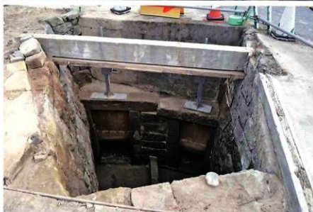
1号水路南端部 (北から)
