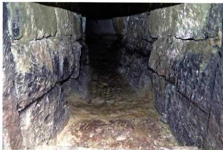
2号用水路（北から）
