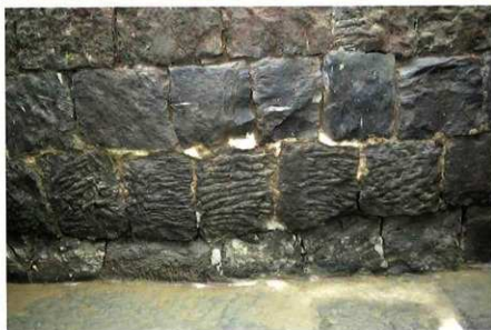
1号用水路南端部東壁面下部
