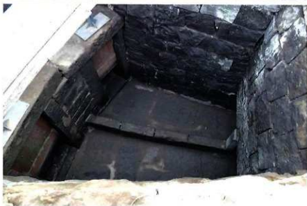
1号水路南端部 (東から)
