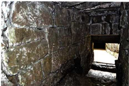
2号用水路①（南から）
