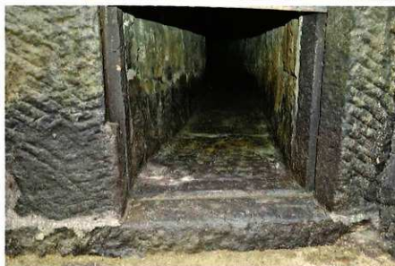
3号水路（北から）
