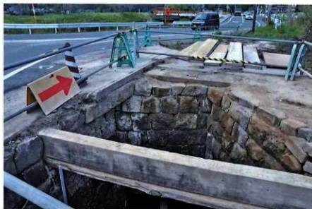
1号水路南端部建物除去後 (南から)
