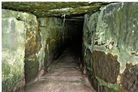
3号用水路㊸ (南から)
