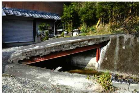
3号用水路南端部 (南から)
