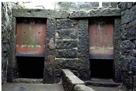
分水樋門（北から）
