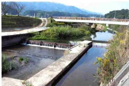
船島堰と導水路（南から）
