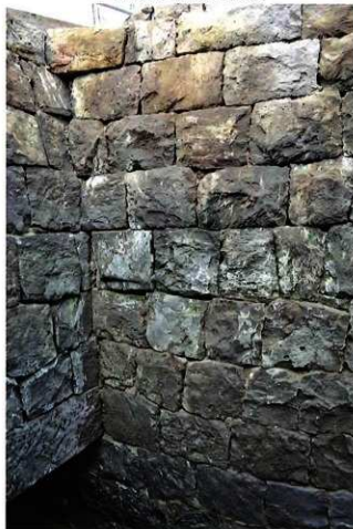
1号水路南端部東壁面①
