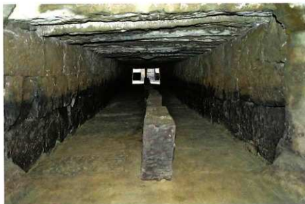
1号用水路樋管部（北から）
