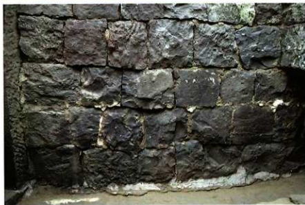
1号用水路南端部西壁面下部
