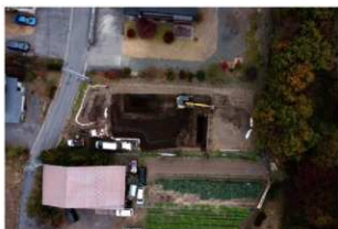
10トレ全景（上が北）
