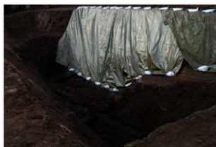
11トレ全景（北東から）
