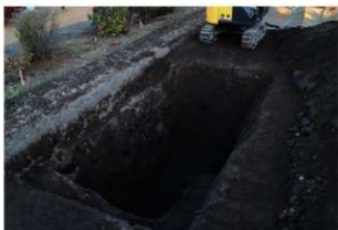
10-2トレ全景（西から）
