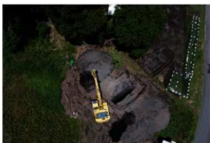
14-3トレ追加1 掘削風景（南から）
