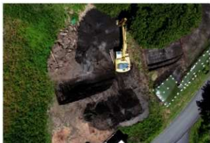
14-3トレ追加2 掘削風景（南東から）
