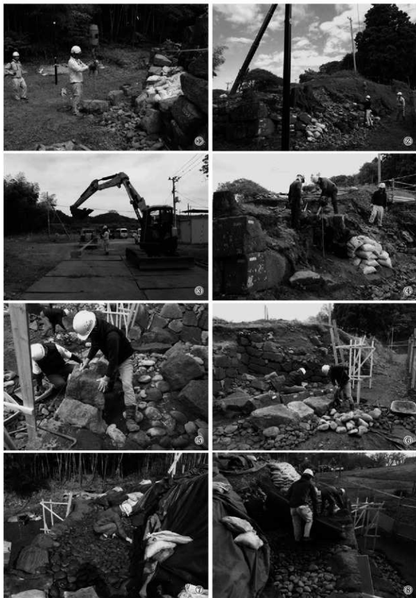
図版 8 施工状況
