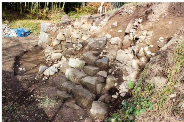
石垣解体完了状況 ①北西から ②南西から
