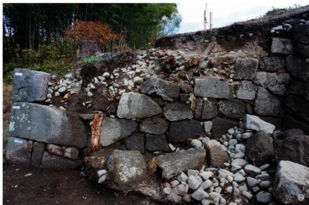
図版4 旧石垣検出状況(1) ①西上空から ②南西から(A面)
