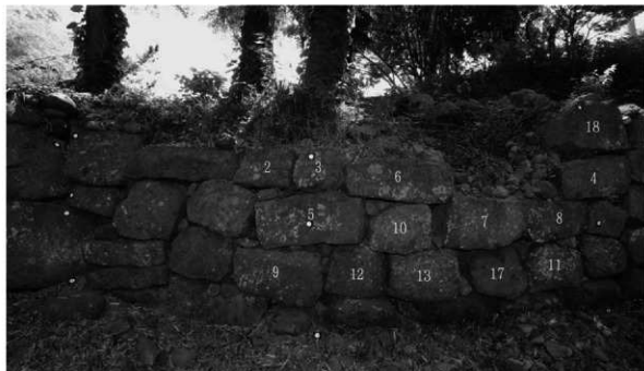
図17 崩落石材の照合
