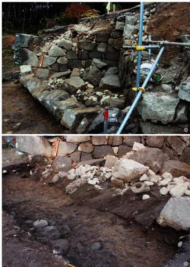
図版9 根石の状況 ①検出状況(南西から) ②解体後状況(南西から)
