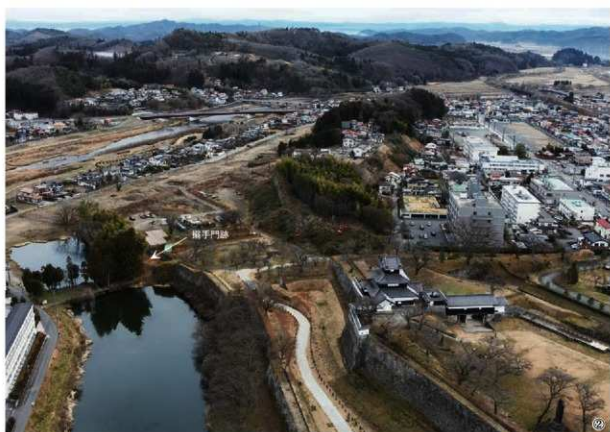
搦手門跡東側遠景
