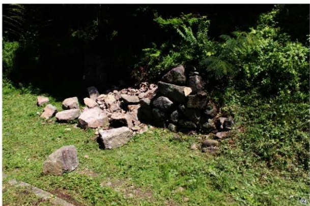
崩落状況 ①北西から ②南西から
