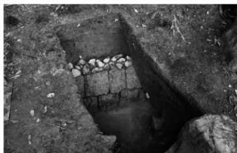
5 T2 旧護岸検出状況 (東から)
