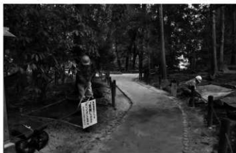
2 T18・T19作業風景（南西から）
