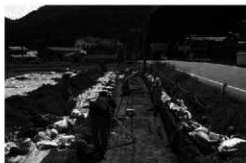
写真1 作業風景1（北東から）
