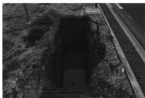
写真9 調査区2完掘状況（北西から）
