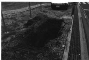
写真8 調査区2掘削状況（北西から）
