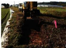
本調査表土剥ぎ
