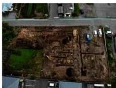
調査地全景 (ドローン) 【西より】
