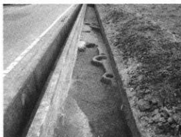
図62 3トレンチ (北から)
