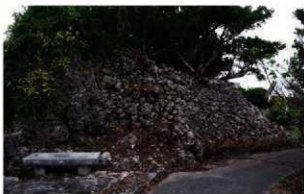
写真7 地区1 南側の石垣（石垣の内側が樋口御嶽）
