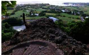
写真14 地区7と地区14を繋ぐ通路の張り出し状の石垣(南東から)
