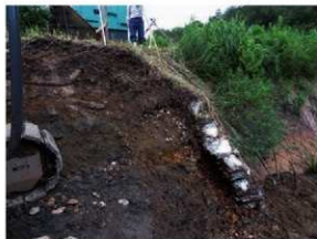
写真16 堤体土層断面(北東から)
