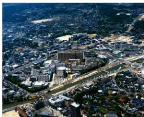
写真13 小串構内航空写真（南東から）
