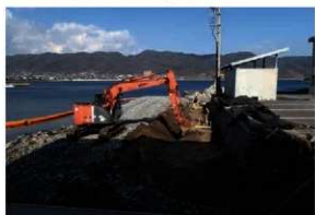
写真 44 調査区東部掘削状況 (南西から)
