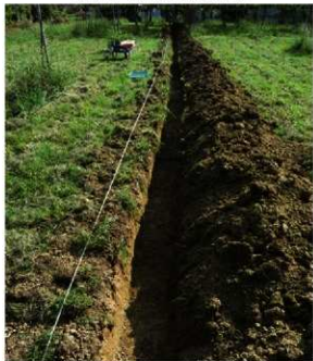
写真18 調査区全景(北から)
