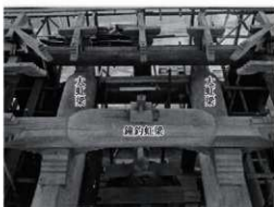
Fig.VII-5-3 東大寺鐘楼 大虹梁と鐘釣虹梁の架構
