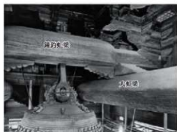
Fig.VII-5-3 東大寺鐘楼 大虹梁と鐘釣虹梁の架構
