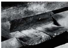
Fig.VI-7-5 醍醐寺五重塔 四重側柱盤木鼻
