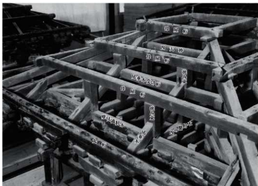
Fig.VI-4-3 元興寺極楽坊五重小塔 三重小屋組(東側)
