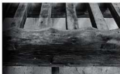
Fig.VIII-3-10 浄土寺浄土堂 鼻隠板（平）
