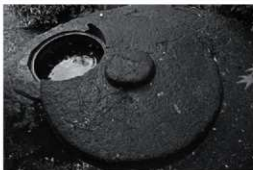
Fig. IV-2-37 藤田美術館所在伝東大寺東塔心礎 (柱座と出納)
