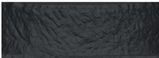
Fig.IV-2-15 東大寺所在伝東大寺東塔心礎 石材①の出納側面の表面加工
