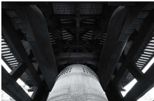
Fig.Ⅶ-4-2 東大寺鐘樓 大虹梁と鐘釣虹梁(西から)
