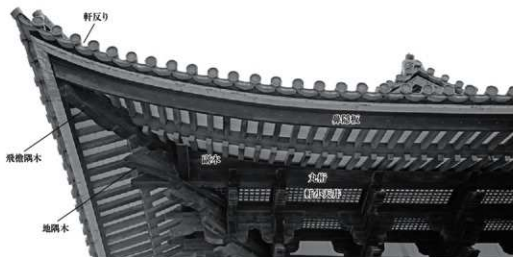
Fig. VII-4-6 東大寺鐘樓 軒まわりの特徴 (西から)
