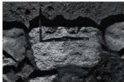
Fig. IV-2-26 鎌倉塔の基壇北面の石敷緑石に残る矢穴(南から)
