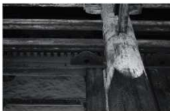
Fig.VIII-3-14 東大寺南大門 下層の露座 (北から)
