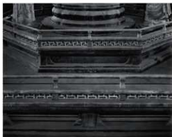
Fig.VI-7-1 東大寺法華堂正堂八角二重仏壇 高欄
