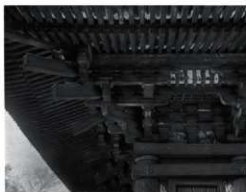
Fig.VI-3-30 教王護国寺五重塔 初重隅の納まり
