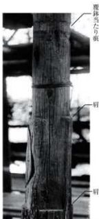
Fig.VI-4-18 海住山寺五重塔 心柱の肩
