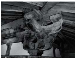
Fig.VI-3-36 東大寺法華堂正堂 入側柱筋の隅の柱上の組物
