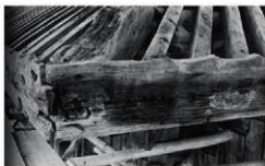
Fig.VIII-3-11 浄土寺浄土堂 鼻隠板（隅）
