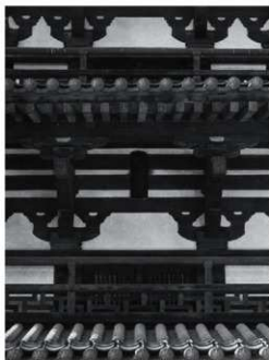
Fig.VI-8-8 法隆寺五重塔 板額 (二重南面)
