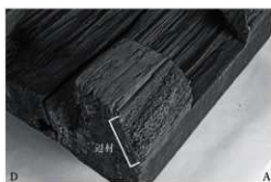
Fig. Appx.Ⅱ-2-16 伝東大寺転害門所用大斗の辺材と判断した箇所
