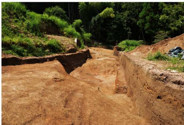
SZ1掘削状況（南から）
