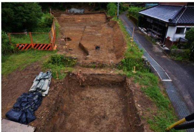
1区調査区中央全景（南から）
