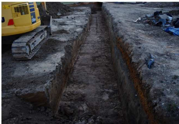
下層確認調査坑南壁（西から）
