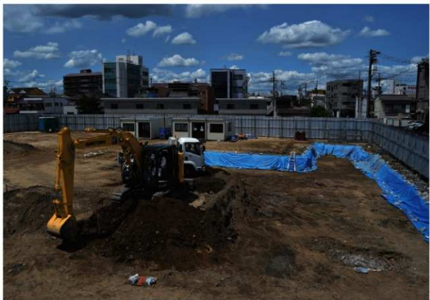
1区 表土掘削状況（南西から）
