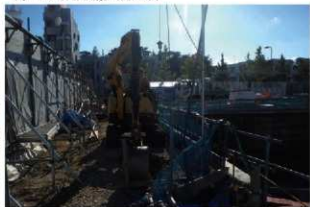
同 No2 作業風景 (北から)
