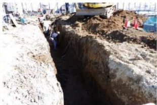
同 No1 作業風景 (西から)
