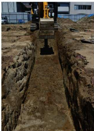
下層確認1 全景 (東から)
