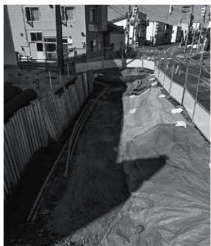
80cm掘削完了 地番 15-3 地先 東から
