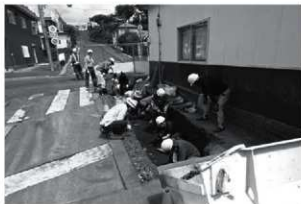
調査状況 南西から
