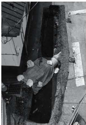
80cm掘削完了 北から
