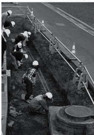
調査状況 地番 87 地先 西から
