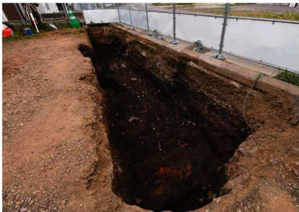
火災面 磁器片出土状況 D地区 地番15-2 IV層 東から
