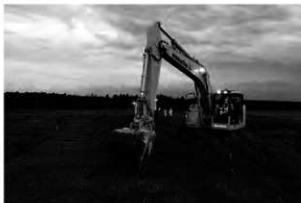
2 表土除去作業 (北東から)
