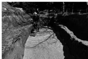
転圧作業（22A区）
