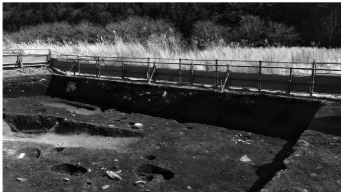
第16図 深掘前状況(北西から)
