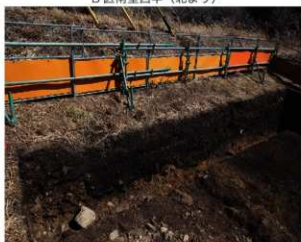
B区東壁（北西より）
