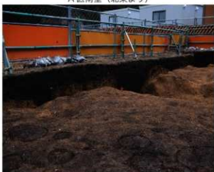
A区南壁西部（北東より）
