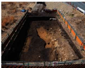
B区検出状況(東より)
