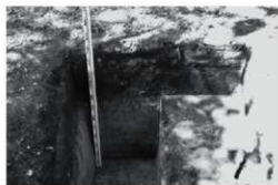
H、ワイン研修センター改修室外機基礎その他敷設工事 TP05（東より）調査番号：2205
