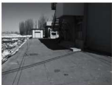
A. 確認調査前の状況（遠景：南より）
