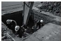
A. 調査の様子 (TP 01 : 北東より)
