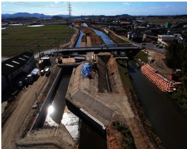
調査区遠景（北より）
