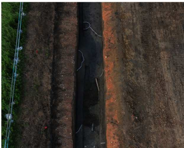
A 区 006SD（南より）
