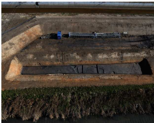
A区下面 (西より)
