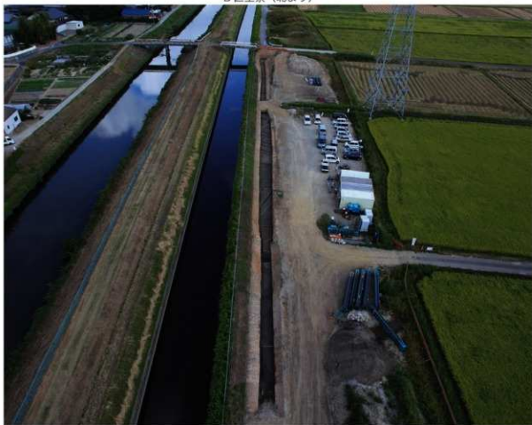
B区全景（南より）
