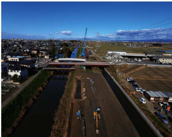
調査区透景（南より）
