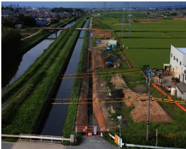
A区全景（南より）
