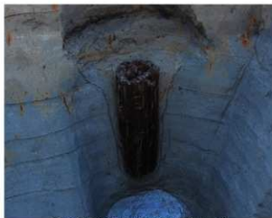
C区 050SK 断ち割り状況（西より）
