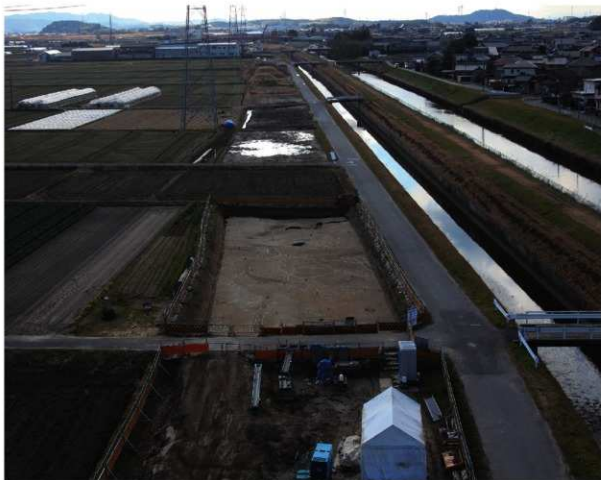
調査区遠景（北より）
