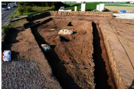
A区VIa層上面(南から)
