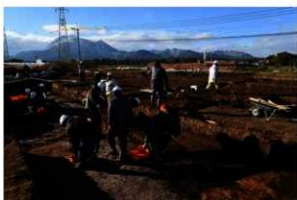
寒波後の霜取り作業状況
