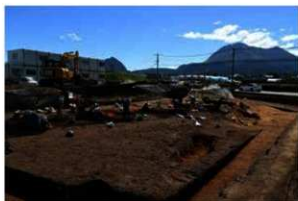
SD1掘削状況①
