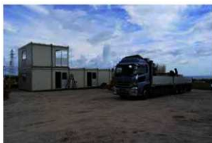
機材等搬入状況
