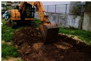
2. 重機掘削（南から）
