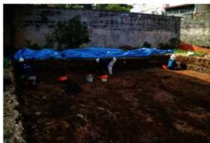
5. 壁面整形作業（北から）
