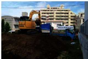
4. 排出土運搬（東から）
