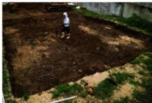
3. 磁気探査作業（南から）
