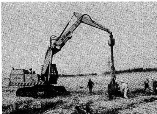
テストピット調査風景
