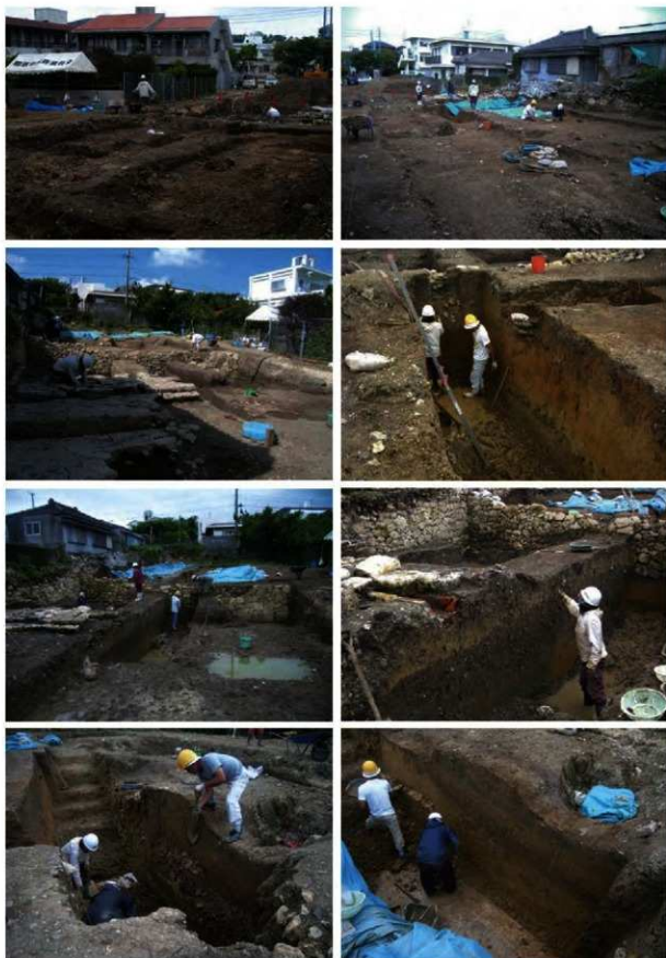
図版 1 掘削作業状況
