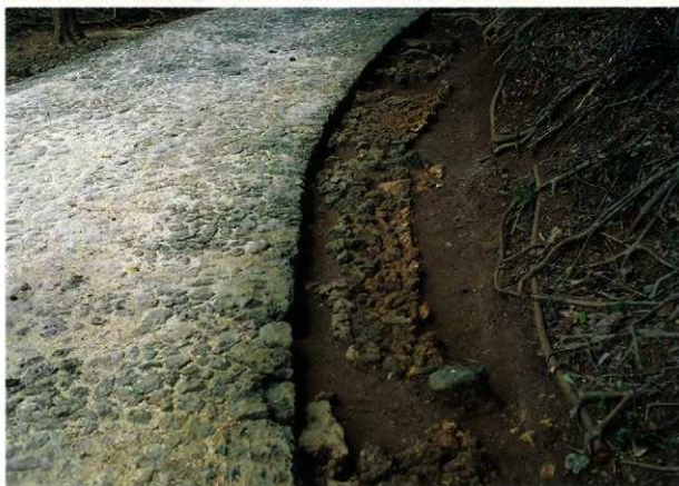
図版3 上：正門からの園路 右側集石遺構検出状況 下：正門からの園路 左側集石遺構検出状況
