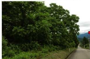
写真8 南側斜面(県道沿い) 整備前
