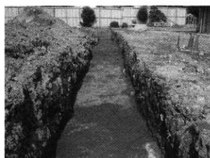
図 63 調査区 2 全景 (西より)
