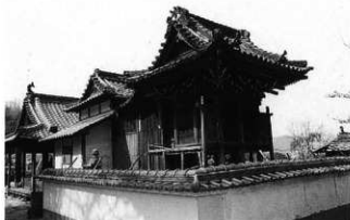
写真272 本殿全景(背面から)
