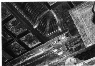
写真21 聖徳殿前殿内陣天井折上部組物の切断状況
