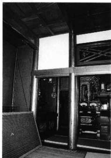
写真240 本堂余間須弥壇改造の痕跡
