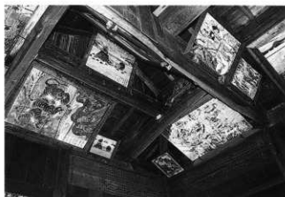
写真226 拝殿内部見上げ
