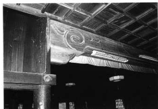
写真22 聖徳殿前殿内陣背面的柱切断後に挿入した虹梁
