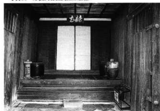
写真81 庫裏式台玄関内部
