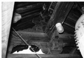
写真128 鐘樓内部見上げ
