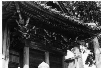
写真274 本殿本体部詳細
