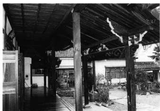
写真138 本堂正面広縁部
