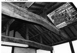
写真210 舞台内部架構
