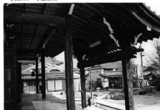
写真261 本堂正面広縁部
