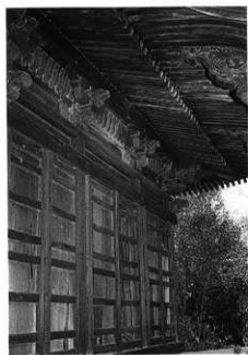
写真65 天神社本体部軸部
