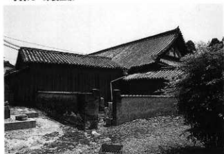
写真74 庫裏背面全景
