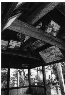
写真170 拝殿内部見上げ
