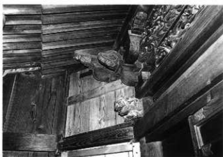
写真223 本殿本体部組物
