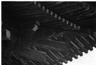
写真45 三重塔二層隅持送彫刻
