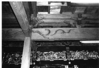
写真121 本堂外障架構
