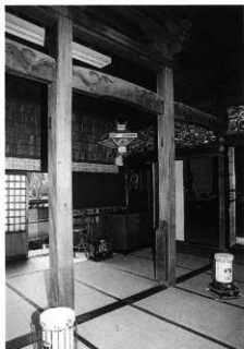
写真148 本堂外陣架構
