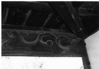
写真133 鐘樓門下層虹梁
