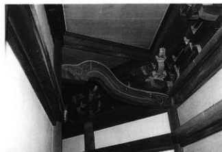
写真39 聖徳殿後殿側通り架構・組物
