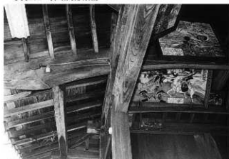
写真283 拝殿内部虹梁の先端 (高落桁となる)
