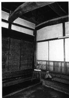
写真76 庫裏土間玄関部分
