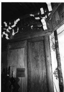
写真307 本殿本体部詳細
