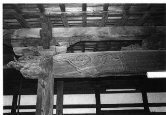
写真316 本堂向拝虹梁
