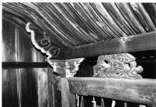
写真276 本殿向拝見返し
