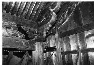
写真222 本殿向拝見返し
