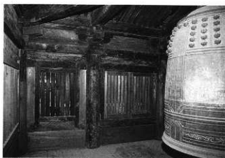
写真55 鐘楼上層内部
