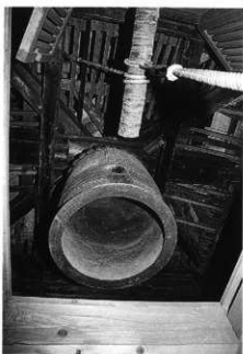
写真53 鐘楼内部見上げ
