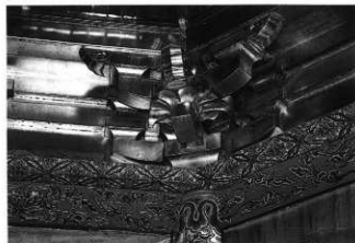
写真38 聖徳殿後殿入側柱内部組物
