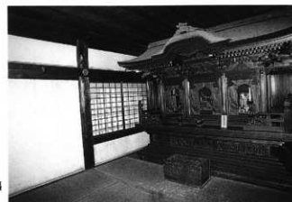
写真39 聖徳殿後殿側通り架構・組物
