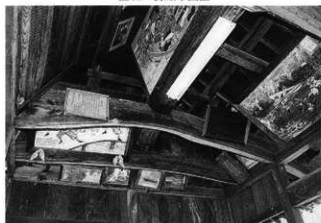
写真282 拝殿内部架構
