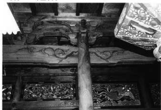
写真332 本堂外陣架橋
