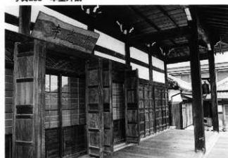
写真260 本堂正面軸部
