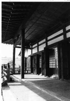
写真288 本堂正面軸部
