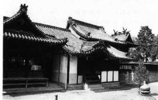
写真207 舞台・幣殿外観
