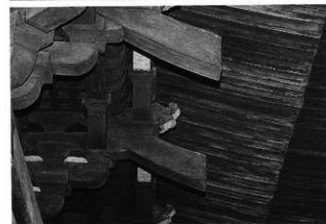
写真50 三重塔初層組物
