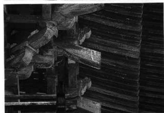
写真49 三重塔二層組物
