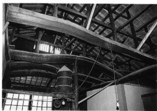
写真100 庫裏東側張出部小屋組
