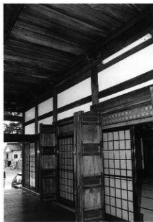
写真317 本堂正面広縁
