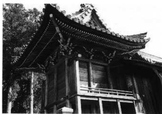
写真302 本殿全景 (背面から)
