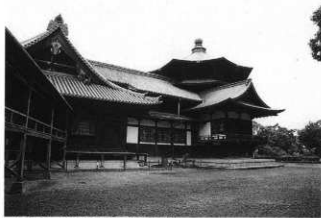
写真27 聖徳殿中殿・後殿外観
