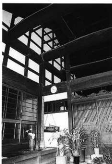
写真298 庫裏土間部分
