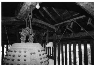
写真135 鐘樓門上層内部
