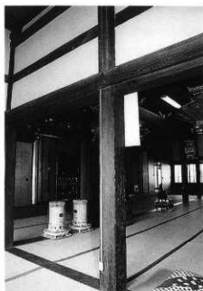
写真253 本堂外陣側面
