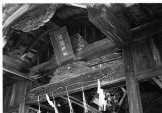
写真203 拝殿正面詳細
