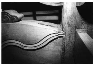
写真292 本堂外障後補の虹梁の柱との取り合い
