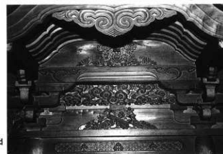
写真41 聖徳殿後殿張出 部厨子詳細
