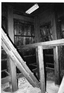
写真54 鐘楼下層内部
