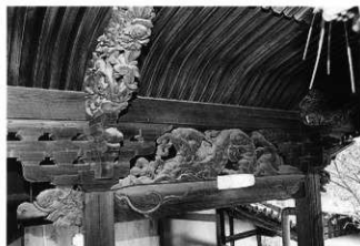
写真200 本殿向拝見返し
