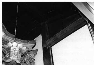
写真322 本堂内陣改造痕跡
