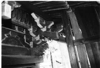
写真275 本殿本体部組物
