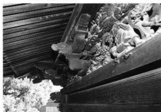
写真201 本殿本体部詳細
