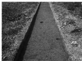
第30図 トレンチ全景(南より)
