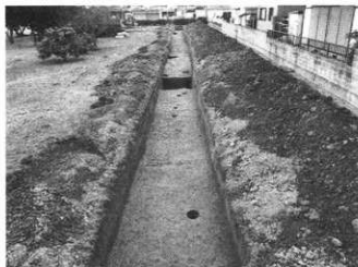
図15 1トレンチ全景（北から）
