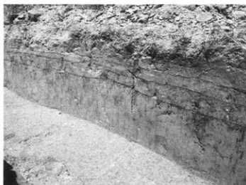
図46 No.2 トレンチ土層
