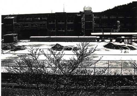
調査地区 No. 1～3 トレンチ (北から)
