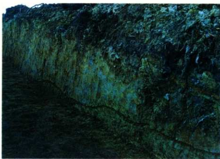
T-30土層 (浚深盛土部分)
