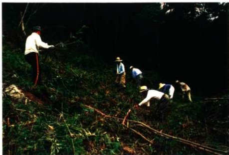
伐開作業風景
