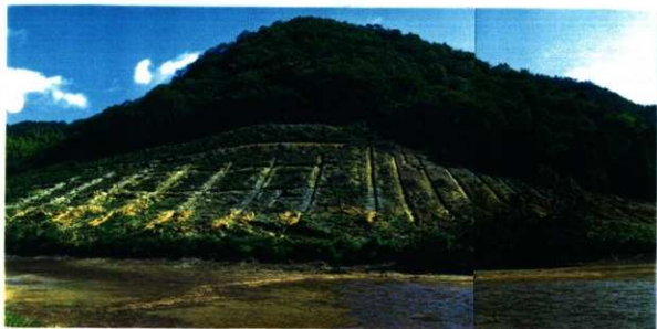
調査地区全景（調査終了後）
