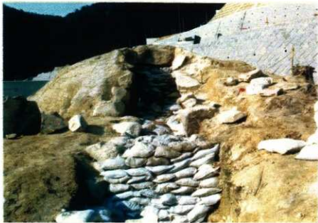
復元作業状況（石室内埋戻完了状況）
