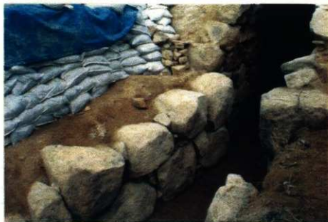
同羨道部崩落状況（南東から）
