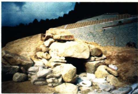
石室復元完了状況
