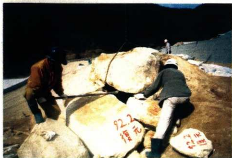
復元作業状況（石材据付作業状況）
