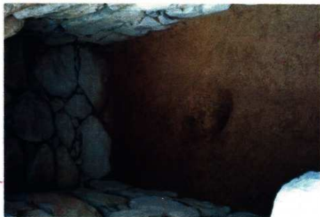
敷石面除去後
