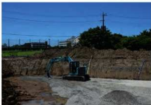
8 同左工事掘削状況
