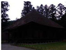
【写真 3-4-9】 施工前（平成 24 年 4 月）
