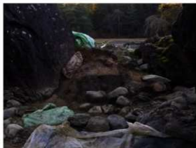
[写真 3-2-67] 汀部分の段差 (東側)
