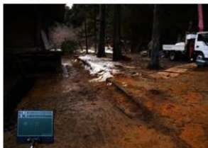
[写真 3-5-24] 常行堂北側 素掘り側溝設置前
