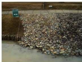
【写真 3-3-5】A区施工後
