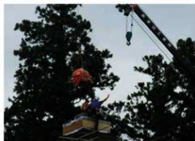
[写真 3-4-41] 宝珠取付け施工状況
