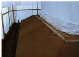
[写真 3-4-64] 亀腹修理 / 漆喰タタキ仕上げ
