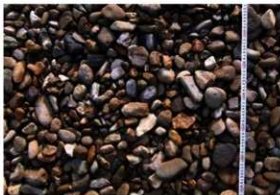
【写真 3-2-72】第2期州浜面（西側） 西側拡張部の全体に自由礫が厚く撒かれている。
