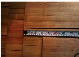
[写真 3-4-35] 榻葺きの重ね寸法
