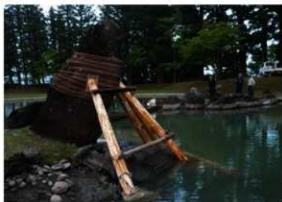
【写真 3-2-23】 仮設養生施工後（西から）
