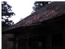
【写真3-4-1】常行堂南面/茅葺き屋根の状況 (平成24年9月)
