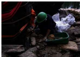
【写真 3-2-36】立石復旧工 / 裾部への粘土補充
