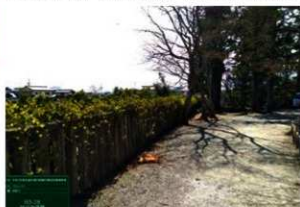
[写真 3-6-137] ブロック No.3・樹木 No.20/ 伐採後
