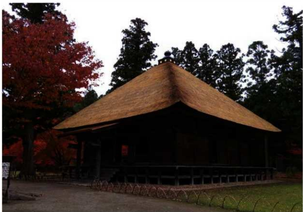
【巻頭図版3】常行堂修理後（平成26年11月撮影）
