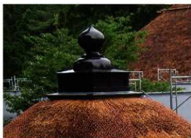
[写真 3-4-60] 露盤及び宝珠取付け完了
