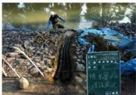
[写真 3-3-10] B区埋設管設置状況
