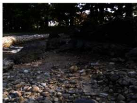
[写真 3-2-87] 第1期州浜北側（施工前 / 西から） [写真 3-2-88] 第1期州浜北側（施工後 / 東から） 表土の補充は行わず、施工前の地形を考慮しながら、円礫を少し厚めに補充した。
