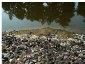
【写真 3-3-2】 土砂流入状況
