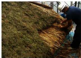
[写真 3-4-51] 茅葺き施工状況 / 解体
