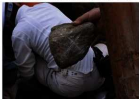
【写真 3-2-37】立石復旧工 / 詰石のマーキング
