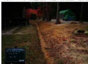
〔写真 3-5-34〕 常行堂北側 斜面叩き締め 着手前
