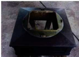
[写真 3-4-57] 露盤補修 / 解体状況
