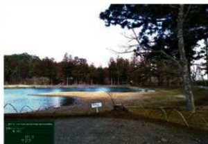
[写真 3-6-131] ブロック No.1・樹木 No.3/ 伐採後
