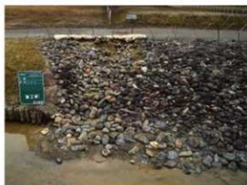
【写真 3-3-4】A区施工前
