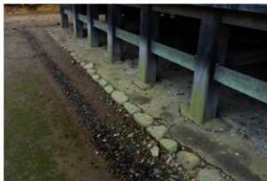
[写真 3-5-7] 常行堂西側雨落ち 着手前
