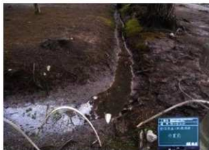
〔写真 3-5-36〕 常行堂南側 既存側溝清掃前
