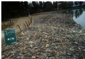
[写真 3-3-13] C区施工後
