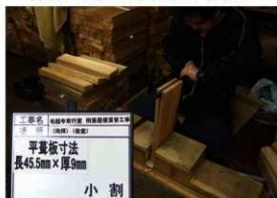
[写真 3-4-28] 平葺板材料加工 / 小割
