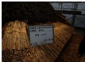
[写真 3-4-52] 茅葺き施工状況 / 水切り部
