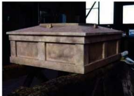
[写真 3-4-58] 露盤補修 / 塗膜除去
