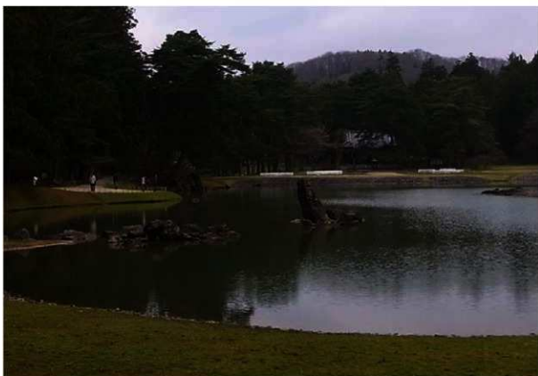
[写真 3-2-94] 立石修理後（平成 24 年 4 月 26 日撮影）
