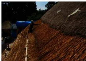
[写真 3-4-13] 茅葺き施工状況 / 平葺き部
