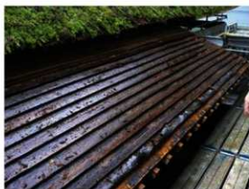
[写真 3-4-22] 下屋庇施工前
