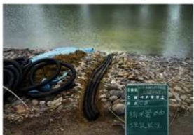
[写真 3-3-14] C区埋設管設置状況
