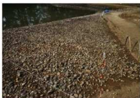
[写真 3-3-27] 州浜清掃施工後
