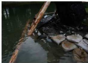
【写真 3-2-26】 松丸太の水中固定状況
