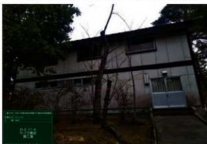
[写真 3-6-161] ブロック No.9・樹木 No.27,A/ 大枝おろし後
