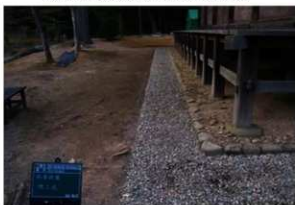
[写真 3-5-13] 常行堂西側 雨落ち修理後
