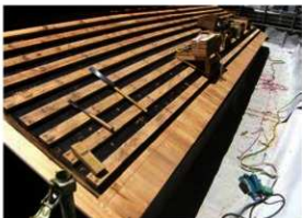
[写真 3-4-31] 下地材施工状況 1
