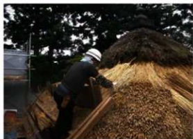
[写真 3-4-53] 茅葺き施工状況 / 平葺き部
