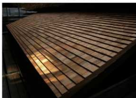
[写真 3-4-36] 榻葺き完成状況
