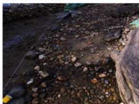
[写真 3-2-85] 第1期州浜南側（試験施工前 / 東から） [写真 3-2-86] 第1期州浜南側（試験施工後 / 東から） 試験施工用の縄張り内で自由礫を補充。写真中央部の固定礫欠損部分でも円礫1～2層の補充であった。
