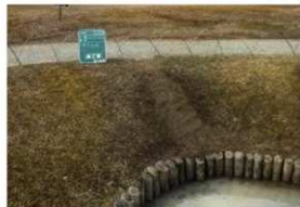
【写真 3-3-21】 入り江（芝地法面）施工後
