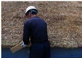
[写真 3-4-17] 茅葺き施工状況 / 水切り部整形
