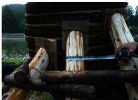
【写真 3-2-25】 立石に接する部分の養生
