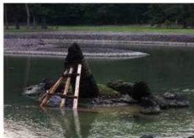
【写真 3-2-22】 仮設養生施工後（南東から）
