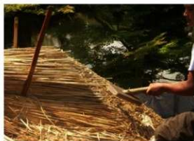
[写真 3-4-54] 茅葺き施工状況 / 平葺き部
