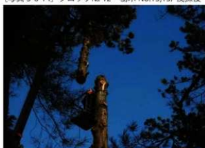
[写真 3-6-16] ブロックNo.12/ 樹木伐採施工状況
