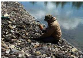
【写真 3-3-18】 D区礫据え直しの様子
