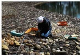
【写真 3-3-19】 D区礫据え直しの様子
