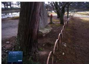
〔写真 3-5-30〕 常行堂南側 土手設置 着手前
