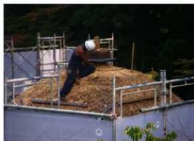
[写真 3-4-40] 宝珠及び露盤の取り外し
