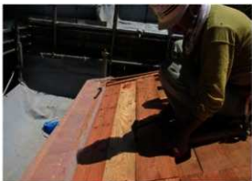
[写真 3-4-33] 下地材作業状況
