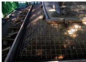
[写真 3-4-62] 亀腹修理 / コンクリート下地用 溶接金網設置
