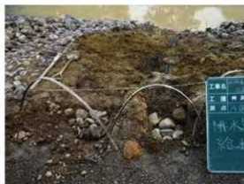
【写真 3-3-7】A区集水口設置状況
