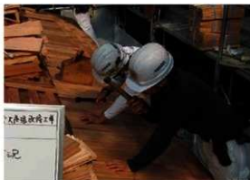
[写真 3-4-34] 榻葺き作業状況
