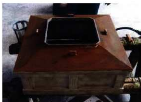
[写真 3-4-59] 露盤補修 / イブシ塗装
