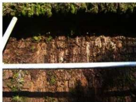
[写真 3-4-19] 上面清掃後の状態
