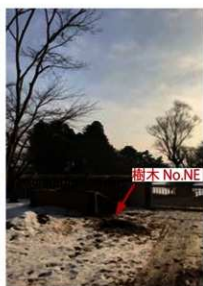
[写真 3-6-41] 樹木 No.NE 伐採後
