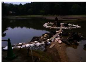
【写真 3-2-29】水替え工 / 設置完了
