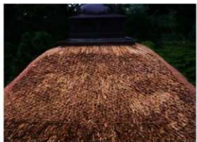
[写真 3-4-55] 茅葺き施工状況 / 防鳥網
