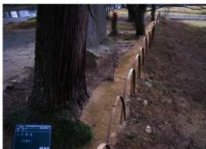
〔写真 3-5-31〕 常行堂南側 土手設置 完了
