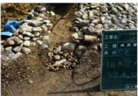
[写真 3-3-15] C区集水口設置状況
