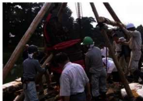
【写真 3-2-32】立石復旧工 / 立石を起こす
