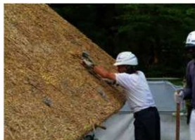
[写真 3-4-16] 茅葺き施工状況 / 平部整形
