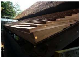
[写真 3-4-37] 榻葺き完成状況 (軒先)
