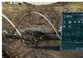
【写真 3-3-23】 入り江（芝地法面）集水口設置状況
