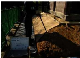
[写真 3-4-61] 亀腹修理 / モルタル撤去
