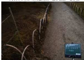
〔写真 3-5-32〕 常行堂南側 素掘り側溝設置 着手前
