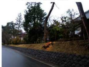
【写真 3-6-129】 町道南 アカマツ撤去後 南東から
