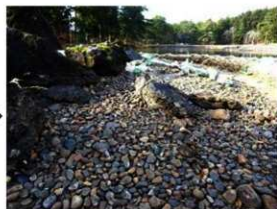
[写真 3-2-87] 第1期州浜北側（施工前 / 西から） [写真 3-2-88] 第1期州浜北側（施工後 / 東から） 表土の補充は行わず、施工前の地形を考慮しながら、円礫を少し厚めに補充した。
