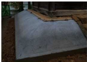
[写真 3-4-63] 亀腹修理 / コンクリート打設
