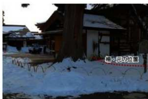
[写真 3-6-19] 南大門横のスギ / 踏圧軽減のための柵移設
