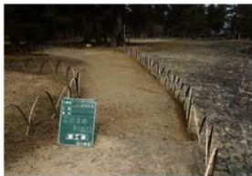
[写真 3-3-25] 園路排水溝施工後
