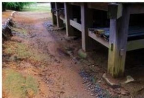
[写真 3-5-6] 常行堂北側雨落ち 着手前
