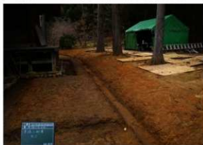
[写真 3-5-25] 常行堂北側 素掘り側溝設置後
