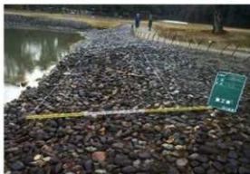
【写真 3-3-16】 D区施工前
