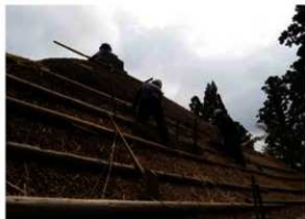
[写真 3-4-12] 茅葺き施工状況 / 平葺き部
