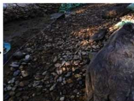
[写真 3-2-85] 第1期州浜南側（試験施工前 / 東から） [写真 3-2-86] 第1期州浜南側（試験施工後 / 東から） 試験施工用の縄張り内で自由礫を補充。写真中央部の固定礫欠損部分でも円礫1～2層の補充であった。
