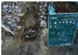
[写真 3-3-11] B区集水口設置状況
