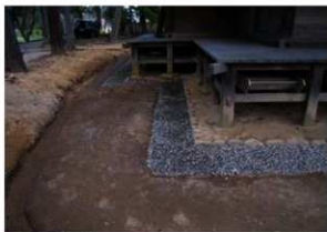
[写真 3-5-15] 常行堂北側 雨落ち修理後
