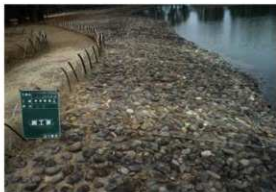
[写真 3-3-9] B区施工後
