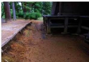
[写真 3-5-5] 常行堂北側斜面と雨落ち 着手前
