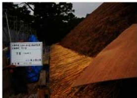
[写真 3-4-11] 茅葺き施工状況 / 水切り部
