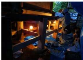
[写真 3-4-45] 常行堂北面 / 縁束修理状況
