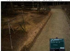
〔写真 3-5-33〕 常行堂南側 素掘り側溝設置 完了
