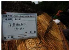
[写真 3-4-14] 茅葺き施工状況 / 針葺き部
