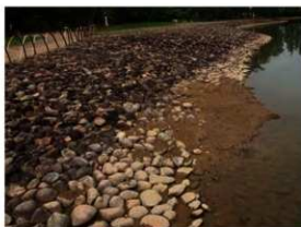
【写真 3-3-3】 土砂流入状況
