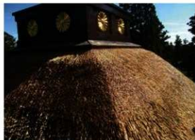
[写真 3-4-43] 露盤周りの銅網設置状況
