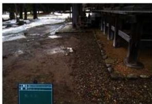
[写真 3-5-16] 常行堂南側 雨落ち修理前
