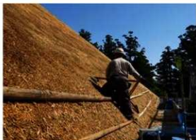
[写真 3-4-15] 茅葺き施工状況 / 桶入れ
