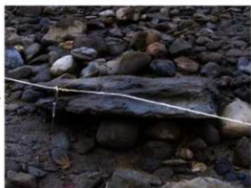
【写真 3-2-92】景石 T14 (施工後)
