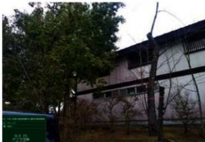
[写真 3-6-159] ブロック No.9・樹木 No.26/ 伐採後
