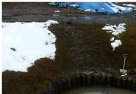
【写真 3-3-20】 入り江（芝地法面）施工前
