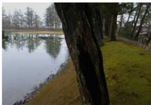
[写真 3-6-122] ブロック No.1・樹木 No.20/ 腐朽状況
