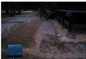
[写真 3-5-17] 常行堂南側 雨落ち修理後
