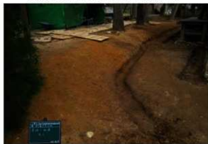
[写真 3-5-23] 常行堂北側 素掘り側溝設置後
