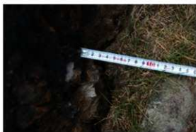
【写真 3-2-8】立石裾部の隙間②（東から）
