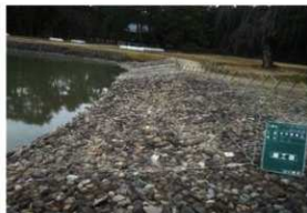
【写真 3-3-17】 D区施工後
