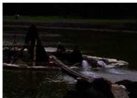
【写真 3-2-30】水替え工 / ポンプによる水抜き
