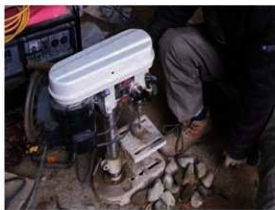
【写真 3-2-81】 ドリルによるマーキング作業
