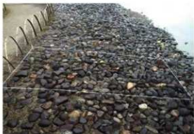
[写真 3-3-8] B区施工前
