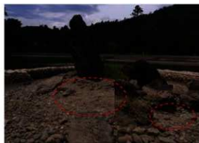
【写真 3-2-74】 第1期州浜（立石の東）欠損箇所
