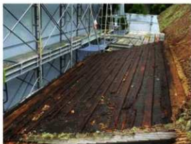
[写真 3-4-20] 葺き撤去状況
