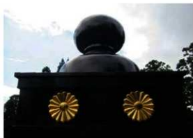
[写真 3-4-42] 宝珠及び露盤の取付け完成状況
