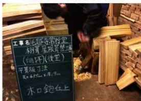
[写真 3-4-27] 平葺板材料加工 / 水口鉋仕上げ
