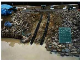
【写真 3-3-6】A区埋設管設置状況
