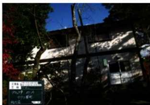
[写真 3-6-160] ブロック No.9・樹木 No.27,A/ 大枝おろし前
