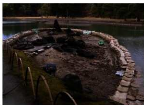
【写真 3-2-79】 水替え工の完了状況
