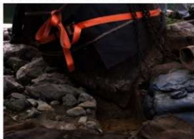
【写真 3-2-35】立石復旧工 / 裾部の状態（東面）
