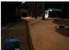
〔写真 3-5-35〕 常行堂北側 斜面叩き締め 完了
