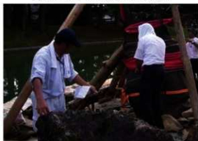
【写真 3-2-33】立石復旧工 / 復旧位置の確認 1
