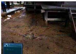
[写真 3-5-14] 常行堂北側 雨落ち修理前
