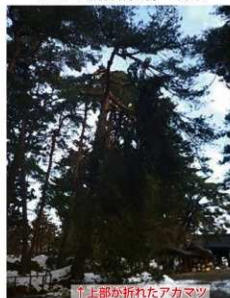
【写真 3-6-126】 宝物館北西 アカマツ被害状況の例 西から
