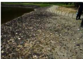
[写真 3-3-26] 州浜清掃施工前
