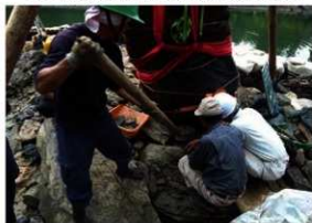
【写真 3-2-38】立石復旧工 / 詰石の突き入れ
