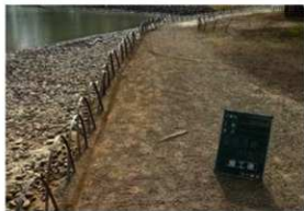
[写真 3-3-24] 園路排水溝施工後
