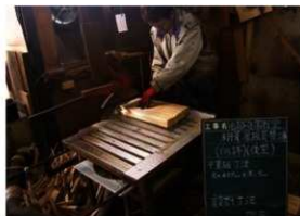
[写真 3-4-26] 平葺板材料加工 / 寸法加工
