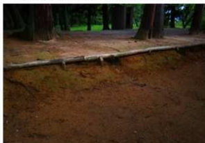
[写真 3-5-4] 常行堂北側斜面 着手前
