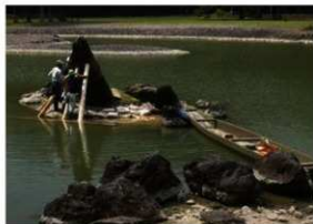
【写真 3-2-24】 仮設養生施工中（南東から）
