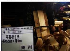
[写真 3-4-29] 平葺板材料加工 / 鉋削
