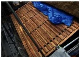
[写真 3-4-32] 下地材施工状況 2
