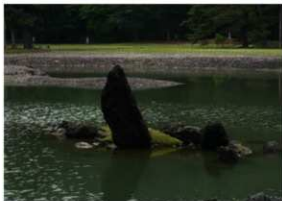
【写真 3-2-21】 仮設養生施工前（南東から）
