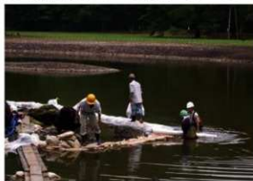
【写真 3-2-28】水替え工 / 遮水シートの設置
