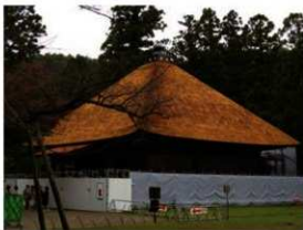
【写真 3-4-10】 大屋根施工後（平成 26 年 10 月）
