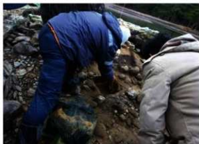
【写真 3-2-80】 現地指導による確認状況
