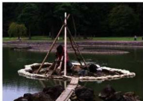
【写真 3-2-31】立石復旧工 / 四又設置
