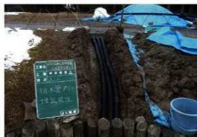
【写真 3-3-22】 入り江（芝地法面）埋設管設置状況
