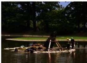
【写真 3-2-27】水替え工 / 土嚢の設置
