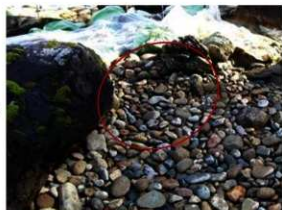
【写真 3-2-90】第1期州浜南側取り合い部 (施工後)
