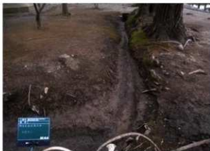
〔写真 3-5-37〕 常行堂南側 既存側溝清掃後
