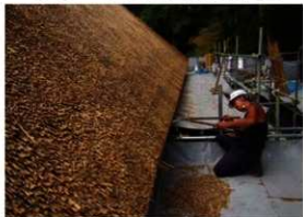
[写真 3-4-18] 茅葺き施工状況 / 水切り部整形
