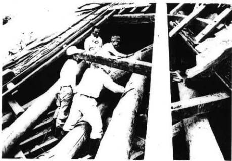
図版19 斑鳩寺講堂 修理中 正面東南側 (小屋組の補修作業風景)
