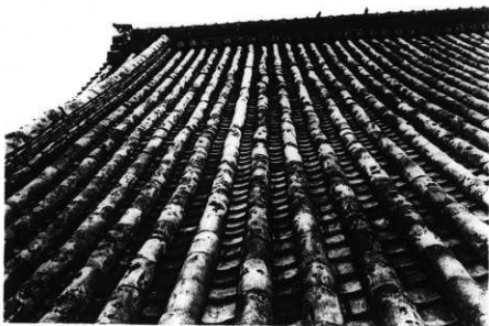
図版 3 斑鳩寺講堂 修理前 正面屋根の状況
