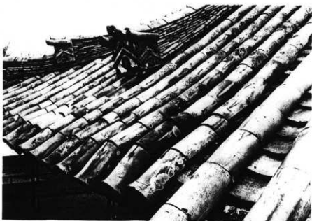
図版 4 斑鳩寺講堂 修理前 正面屋根の軒端状況
