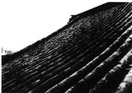
図版 7 斑鳩寺講堂 修理前 正面屋根の状況 (葺瓦は劣化が著しい。)
