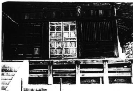
図版23 斑鳩寺講堂 竣工 西側側面 (建具の補修)
