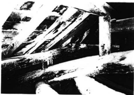
図版16 斑鳩寺講堂内部 修理前 西南部 小屋組の腐朽状況 (箕甲尻部の野地は雨漏りの被害をうけ、東踏母屋隅木等の腐朽が著しい。)
