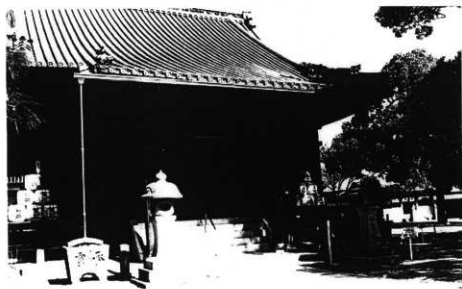
図版24 斑鳩寺講堂 竣工 正面 (軒樋の取替)
