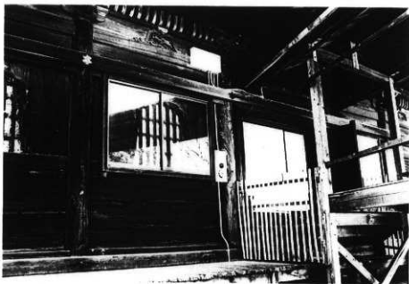
図版27 斑鳩寺太子堂 自火報設備の復旧
