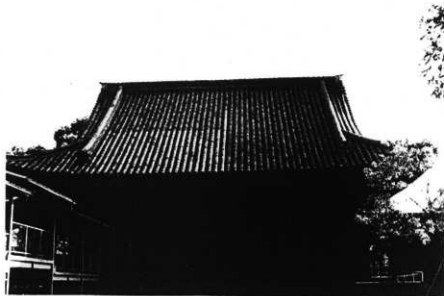
図版 2 斑鳩寺講堂 修理前 背面の状況
