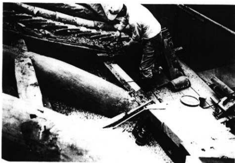
図版20 斑鳩寺講堂 修理中 向拜の軒端 (軒廻りの補修作業風景)
