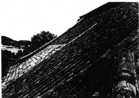
図版 9 斑鳩寺講堂 修理前 背面屋根の状況 (東半部は小修理が行なわれている。)
