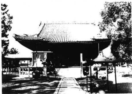
図版 1 斑鳩寺講堂 修理前 正面の状況
