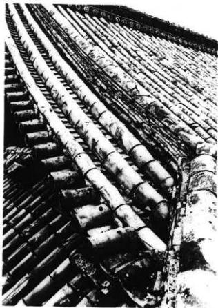
図版11 斑鳩寺講堂 修理前
