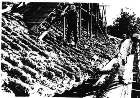
図版21 斑鳩寺講堂 修理中 西側面 (瓦の取り除き作業風景)
