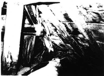
図版15 斑鳩寺講堂内部 修理前 東南部 小屋組の腐朽状況 (東南の野隅木は腐朽落損し、野地や母屋の破損も著しい。)
