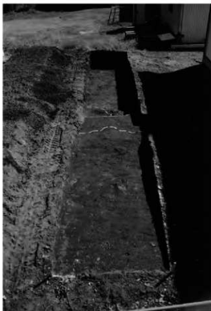
4 76トレンチ全景 (西から)
