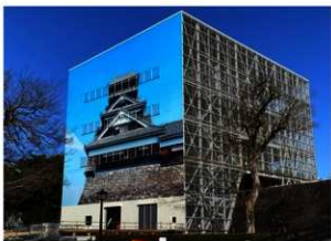
南西から見た宇土櫓素屋根
