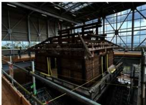
解体が進む3層目
