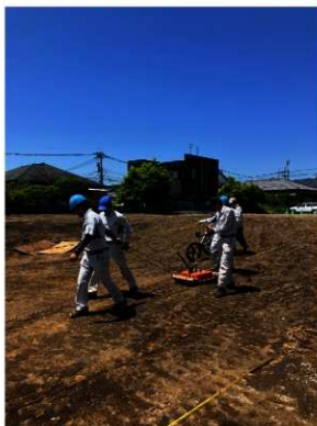
写真3 地中レーダー探査の実施状況
