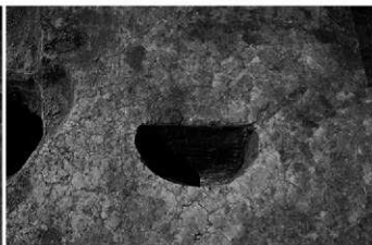
第9次調査 P84 土層断面(南東から)
