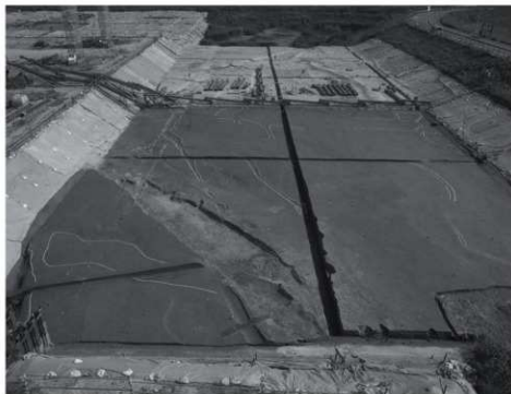
1 1区 第13-1a面 検出状況 (北から)
