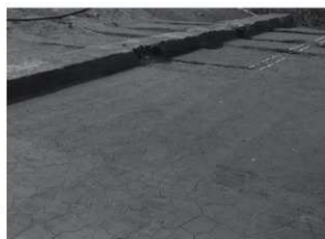
写真5 耕作痕跡 検出状況 (南から)
