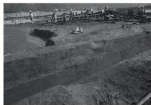
写真15 655流路 (Y=-34,060 ライン) (北西から)
