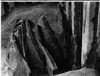
最下層護岸杭(←北)
