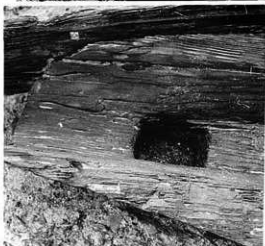
船底部先端枘穴(←南)
